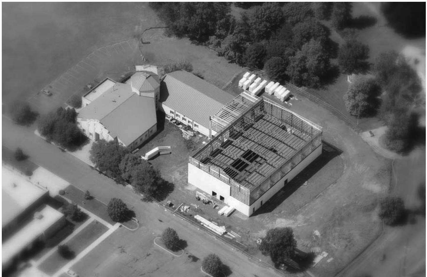
An aerial view of the Consistory and Library (with blue roofs) and new Museum building Вигляд з повітря на Консисторію та бібліотеку (синій дах) та новий будинок музею.
